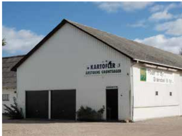
SKILTNING PÅ LANDBRUGSBYGNING I DET ÅBNE LAND
