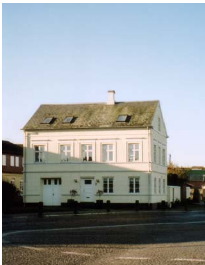
Havnepladsen 2 Den gl. havnefogedbygning
