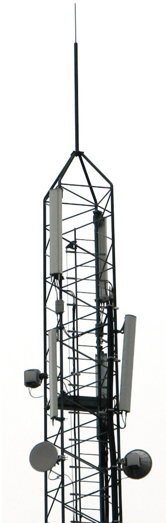
Gittermast med flere antenner
