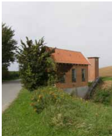
Pumpehus ved Klisebjerg
