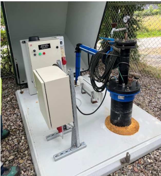
Boring ved Lohals Vandværk
