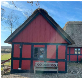
Bygning B3 – facade mod nord
