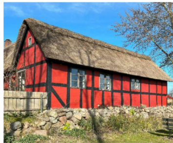
Bygning B3 – facade mod øst
