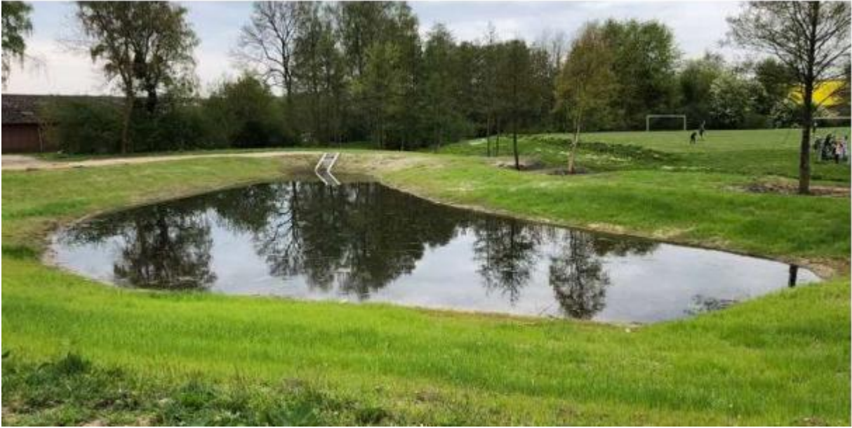
Figur 5 Eksempel på regnvandsbassin hvor der som her er permanent vandspejl.
