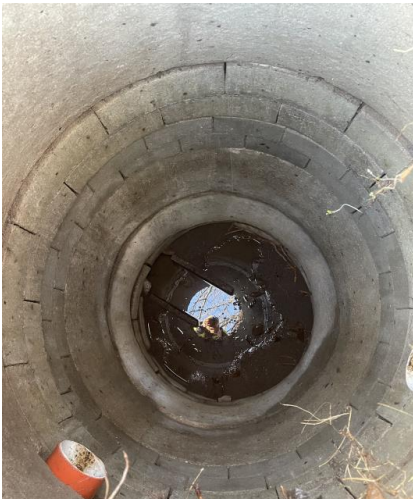
Figur 1 - eksisterende brønd på drænledning ved gl. banelinje
