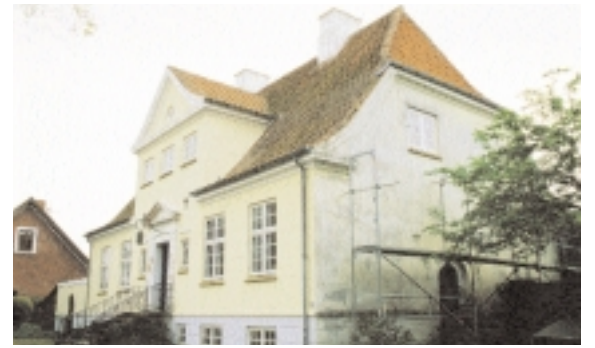
I 1920'erne opførtes en række velbyggede villaer udenfor den gamle bymidte. Som her på Spodsbjergvej 32. Stilen er nybarok i Bedre Byggeskik regi.
