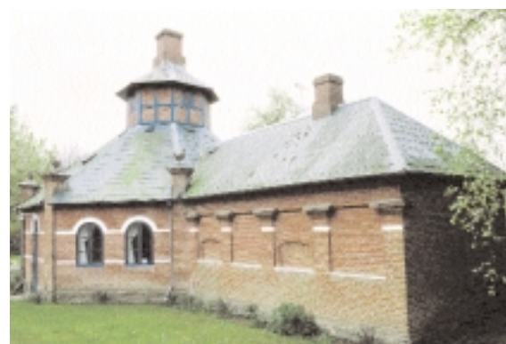
Øst for ladegården ved vejen mod Botofte står det såkaldte Hønsehus. Et overgivent og næsten frivolt byggeri med små hønsestatuer på husets forlængede hjørnepilastre.
