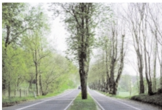
Den gamle, flotte lindeallé, der fører landevejen ind til byen fra nord, er ganske elegant udvidet med en ny kørebane, uden at alléen har lidt overlast.
