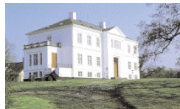
Egeløkkens hovedbygning ligger i ensom majestæt på en lille bakketop med parken nedenfor.
