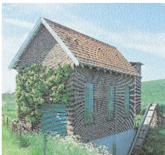
Pumpestationens nyttebetonede arkitektur tegner sin skarpe profil mod himlen.
