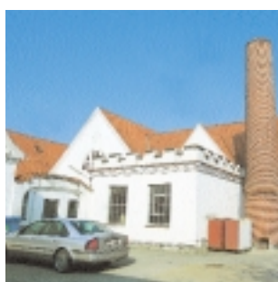
Lejbølle mejeri er stadig et velholdt og spændende bygningskompleks, selv om mælken i dag produceres andre steder.
