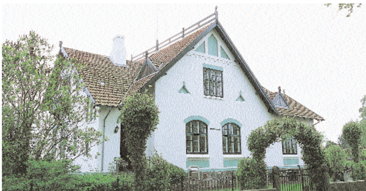
Rue 31 fra år 1900 er et gennemført eksempel på skovvirkestilens motivverden, med bl.a. reminiscenser fra den nordiske vikingetid. Jf. rygningens udvendige tagstol og de dragelinende brandstænger ved alle tagspidserne.
