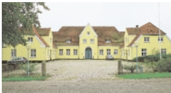
I Magleby, nedenfor kirken mod øst, ses dette fine trelængede Bedre Byggeskik anlæg. Byggeriet er et smukt eksempel på et gennemført grundmuret hus på landet.
