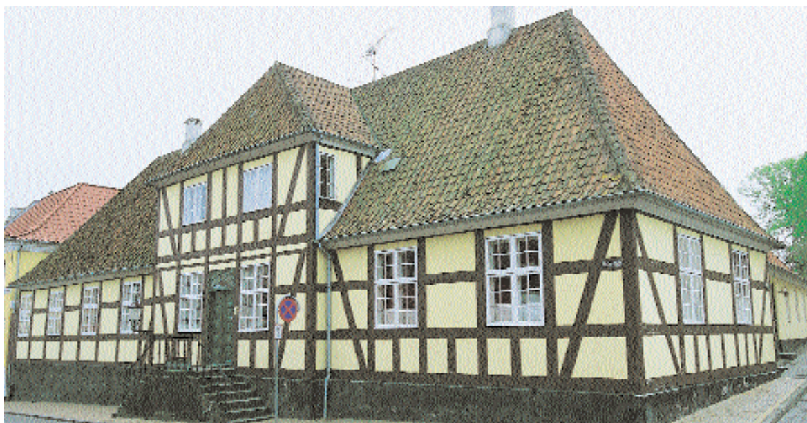
Præstegårdens forhus i Østergade 2 er opført i 1760. Huset står i 18 bindingsværksfag med et helvalmet tag og en dominant afvalmet midtrisalit.
