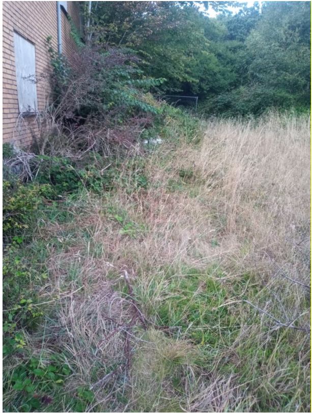
Buskads/krat øst for bygningen
