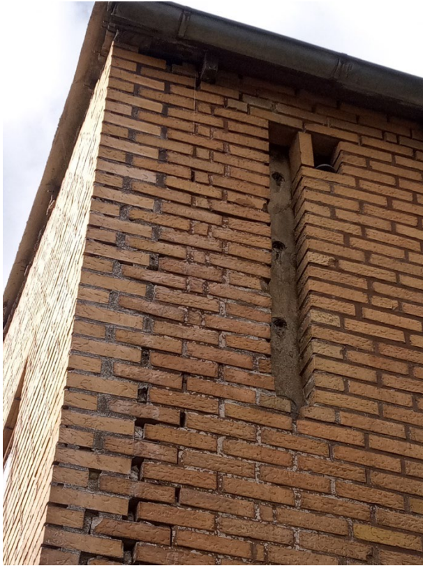
Huller i cement og murværk
