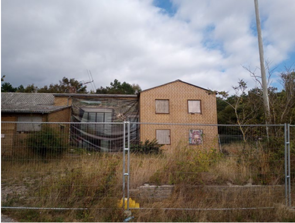
Bygningens sydlige side
