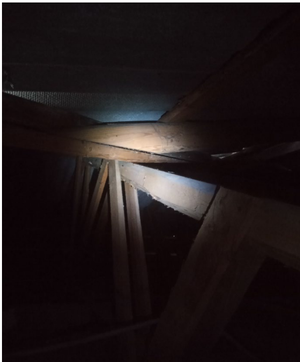
Revner mellem tilsluttede bjælker
