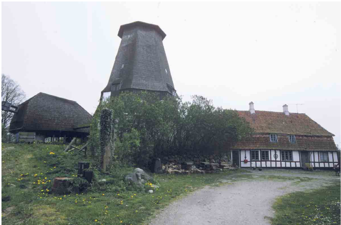
Rudkøbing Mølle står højt på sin banke for enden af Ruestræde. Møllehatten er midlertidigt nedtaget.
