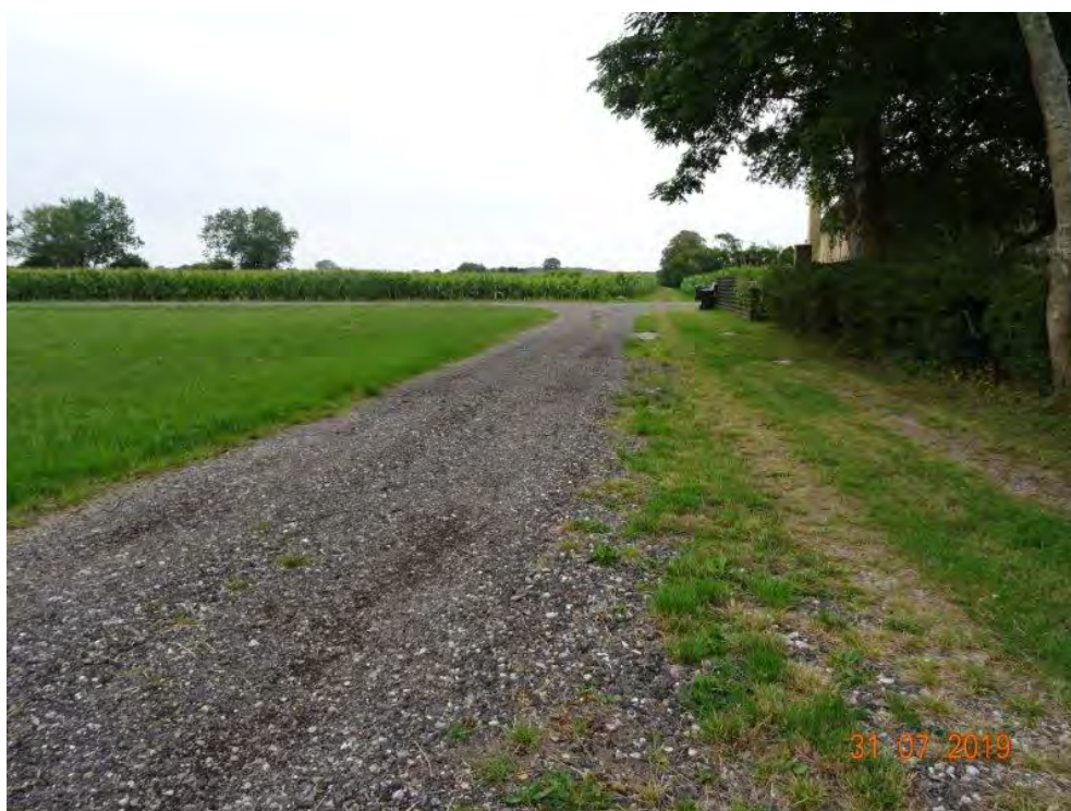
Foto. Vejstrækning med knust asfalt langs privat fællesvej ud for ejendommene Hedevejen 10 og 14. 31.juli 2019.
