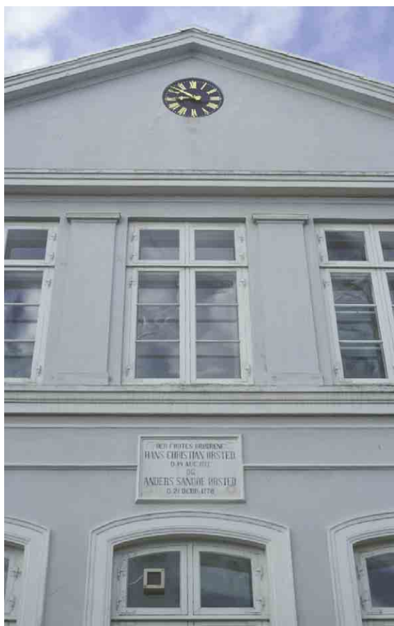
Brogade 15's gavlkvist i gade- facaden. Uret stammer fra en bygning i Tivoli i København.
